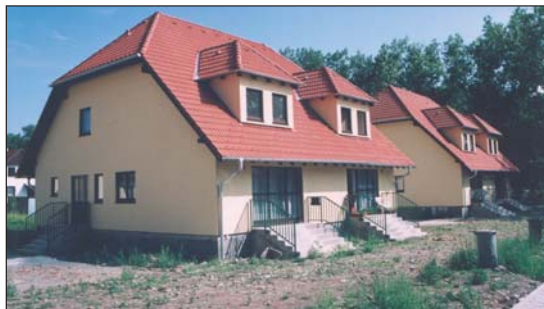
Jeden ze 7 povodňových dvojdomků v obci Štěchovice
